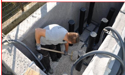
Alle Schläuche beschriften, damit man sie nicht später vertauscht, 8/16 Schotter verteilen
