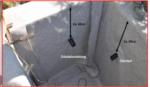
Zirkulationsleitung + Überlauf Ca. -60cm unter 0/0
