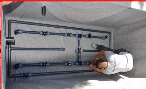
Rückspüleleitung + Filtergestell zentral legen, Verschraubungen fest anziehen
