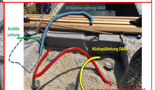
Pumpe und 3 Weg- Kugelhahn an die Leitungen montieren. Saugseitig DA50, Druckseitig DA63
