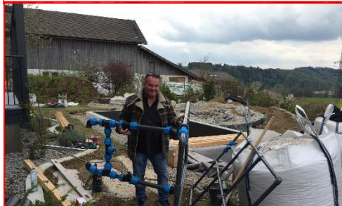
Einbringen der Rückspüleleitung + Filtergestell
