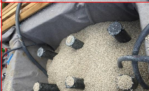
Skimmerteich bis zur Filteroberkante mit 8/18 Schotter füllen.
