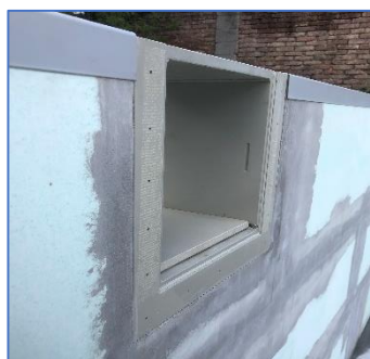
Skimmerklappe vor der Folienverlegung.
