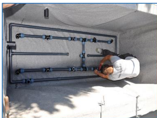
Rückspülleitung und Filtergestell zentral legen und die Verschraubungen festziehen
