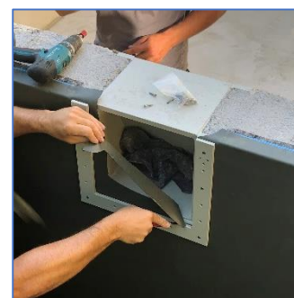
Folie mit einem Cutter ausschneiden.
