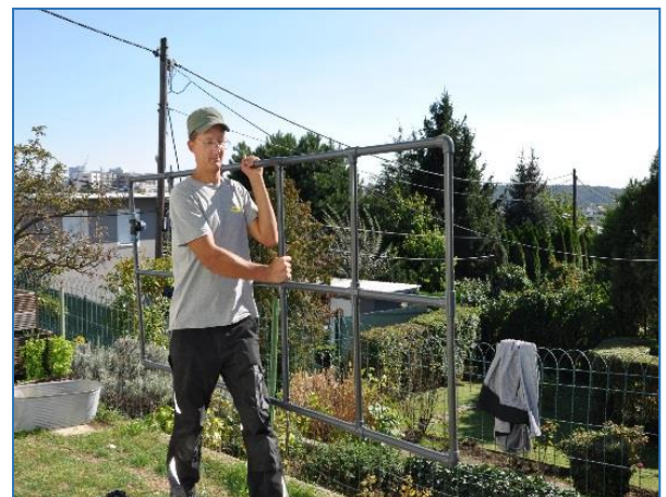
Als nächstes Bubble Leitung einbringen
