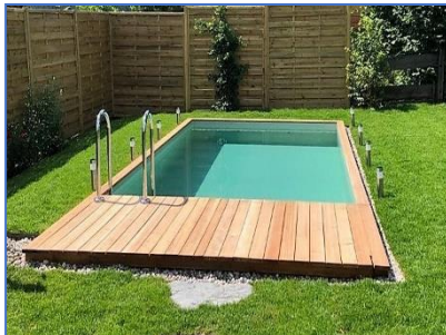
Normaler Einbau +10cm - 15cm Überstand
