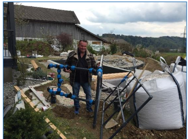
Einbringen der Rückspüleleitung und des Filtergestelles
