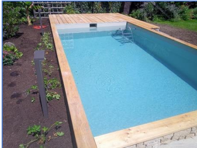
Normaler Einbau +10cm - 15cm Überstand
