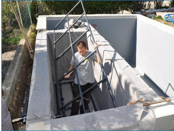
Bubble Leitung in den Skimmerteich einbringen
