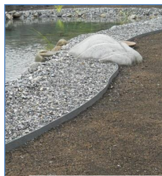
Einbaubeispiele Trennband / Kapillarsperre
