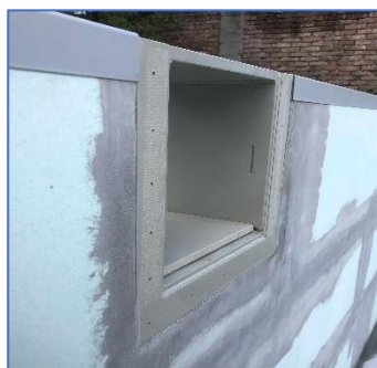
Skimmerklappe vor der Folienverlegung.
