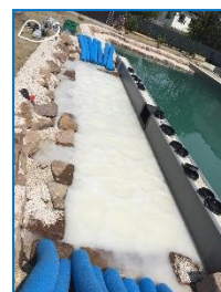
Abb.8 Skimmerteich eines TEOC Naturpools beim Bubbeln (Rückspülen)...
