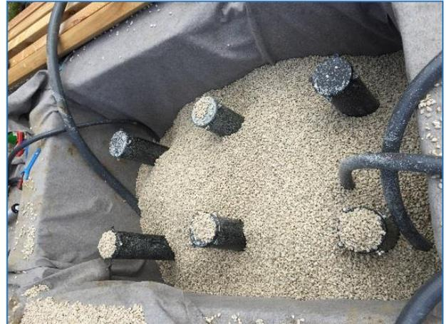
Skimmerteich bis zu unter 2cm der Filteroberkante mit Schotter füllen
