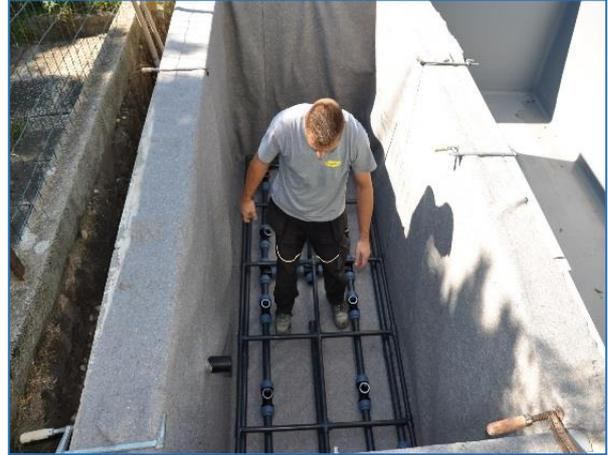
Bubble Leitung mit den **Löchern nach unten** auf die bereits eingebrachten Leitungen legen
