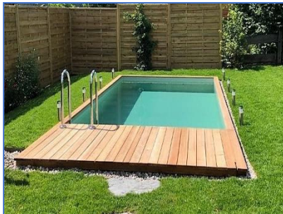
Normaler Einbau +10cm - 15cm Überstand
