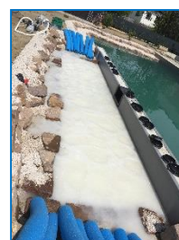
Abb.8 Skimmerteich eines TEOC Naturpools beim Bubbeln (Rückspülen)...
