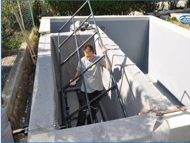
Bubble Leitung in den Skimmerteich einbringen
