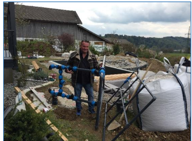
Einbringen der Rückspüleleitung und des Filtergestelles
