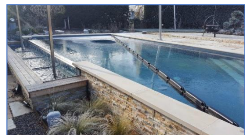
Neu beim TfN: Die Einströmdüsen sind nicht mehr gegenüber der Skimmerklappe, sondern im Skimmerteich verbaut. Dadurch braucht man die Zirkulationsleitung nicht mehr um den TFN legen.
