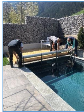
Rollabdeckung in die gewünschte Position bringen.
