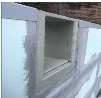
Skimmerklappe vor der Folienverlegung.
