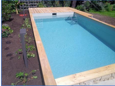
Normaler Einbau +10cm - 15cm Überstand
