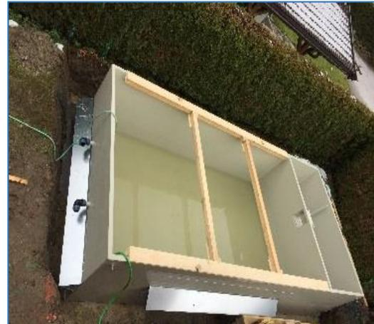
Die Transportsicherung auf Versteifung Funktion überprüfen – diese bleibt bis zum Ende des hinterfüllen montiert
