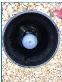
Sobald der Filterboden sichtbar ist, muss der 3- Wege KH vor der Pumpe in die rechts beschriebene Stellung gebracht werden.
