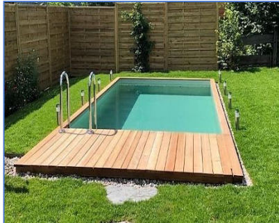
Normaler Einbau +10cm - 15cm Überstand
