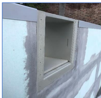
Skimmerklappe vor der Folienverlegung.
