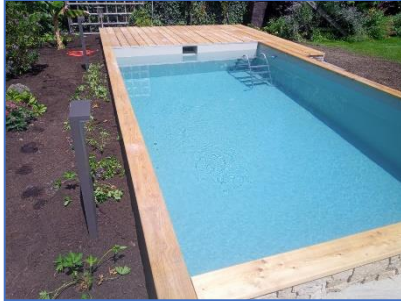
Normaler Einbau +10cm - 15cm Überstand
