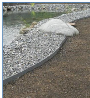
Einbaubeispiele Trennband / Kapillarsperre
