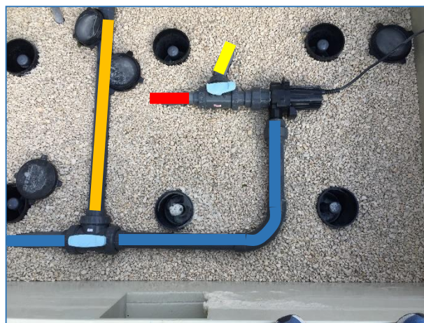
Saugleitung von den TECO Filter – Rückspüleleitung – Zirkulation Leitung – Ablauf Leitung
