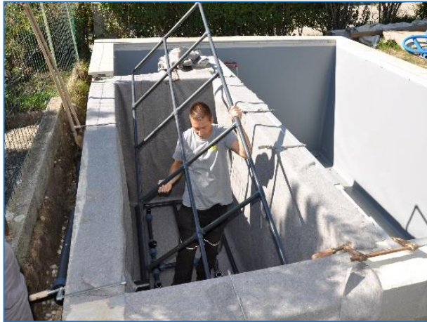
Bubble Leitung in den Skimmerteich einbringen
