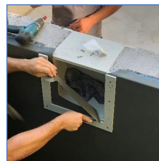
Folie mit einem Cutter ausschneiden.
