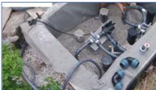
**Tipp:** Damit das Anschließen und verlegen der Schläuche erleichtert wird, kann man frühzeitig etwas unter die Pumpe legen (zb. Schalungsstein) und die Schläuche noch vor dem fertig befüllen des Skimmerteiches montieren. (Untergelegte Teile sind natürlich nach anschließen zeitgerecht wieder zu entfernen!)
